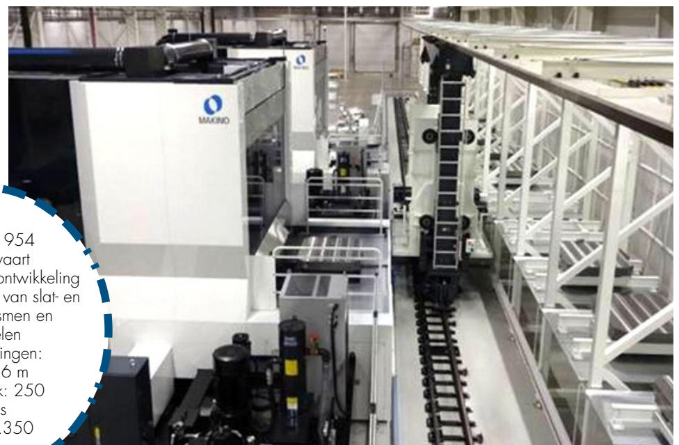
FMS-cel rondom een lineaire robot die is gekoppeld aan vijf T2's van Makino
